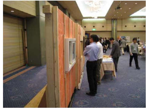
□Q1 住宅付加断熱模型展示状況 (縦胴縁 35mm 付加 横胴縁 45mm 付加 横胴縁 100mm+100mm 断熱)
