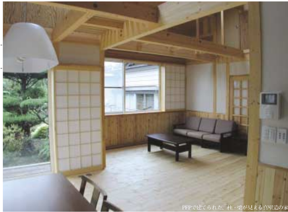
PFPで建てられた、柱・梁が見える真壁造の家。
